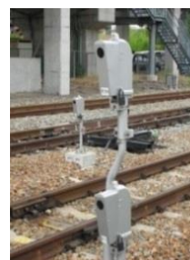
踏切障害物検知装置
